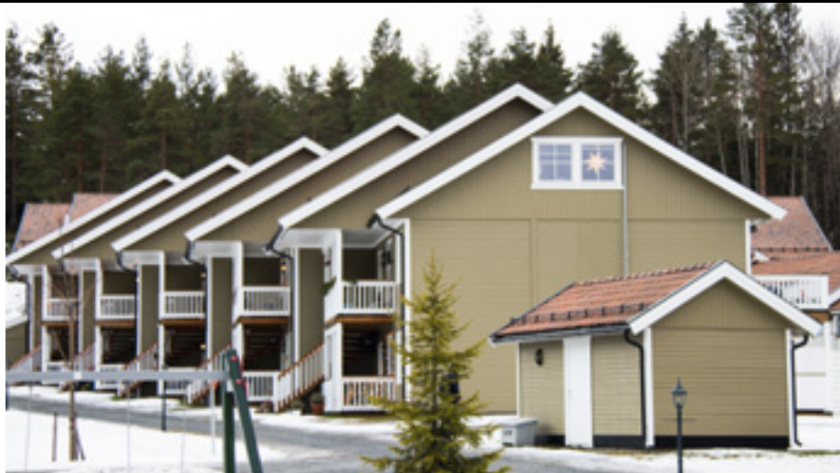
Boligsameiet Rødsåsgrenda har mange boliger. Under oppføringen ble prosjekteringen gjort om slik at alle hus unntatt to ble sprinklet i alle tre etasjer. De to gjenstående husene får sprinkleranlegg i alle etasjer i løpet av 2018.
