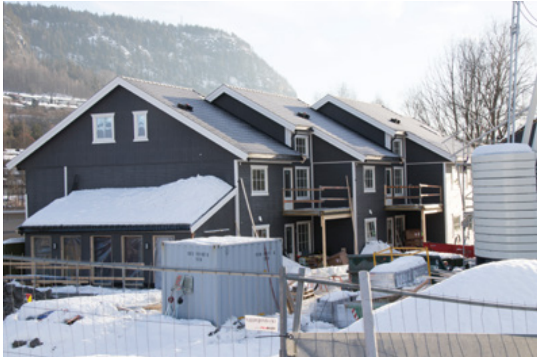
Spikerbruksfallet i Lommedalsveien i Bærum er bygget etter tilsvarende brannkonsept som Trysilhus har benyttet i Asker. Etter tilsynet besluttet Trysilhus å sprinkle alle etasjene i bygget.
